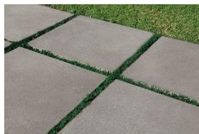
Figure 9 : Revêtement de sol en dalle béton
